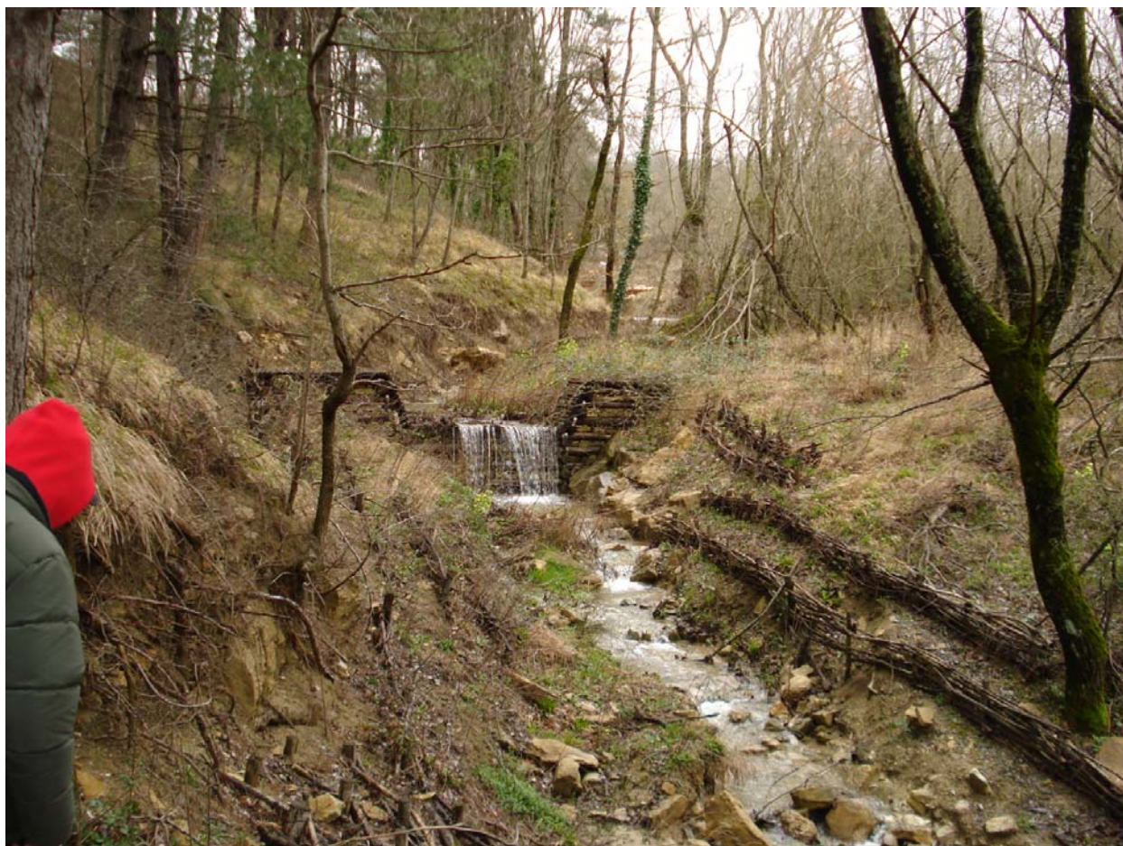
Fig. 15. Briglia mista in legname e pietrame costruita recentemente sul torrente Fiumicello a Celle di San Vito (FG) a completamento di una sistemazione idraulico-forestale eseguita alla fine degli anni Cinquanta.
