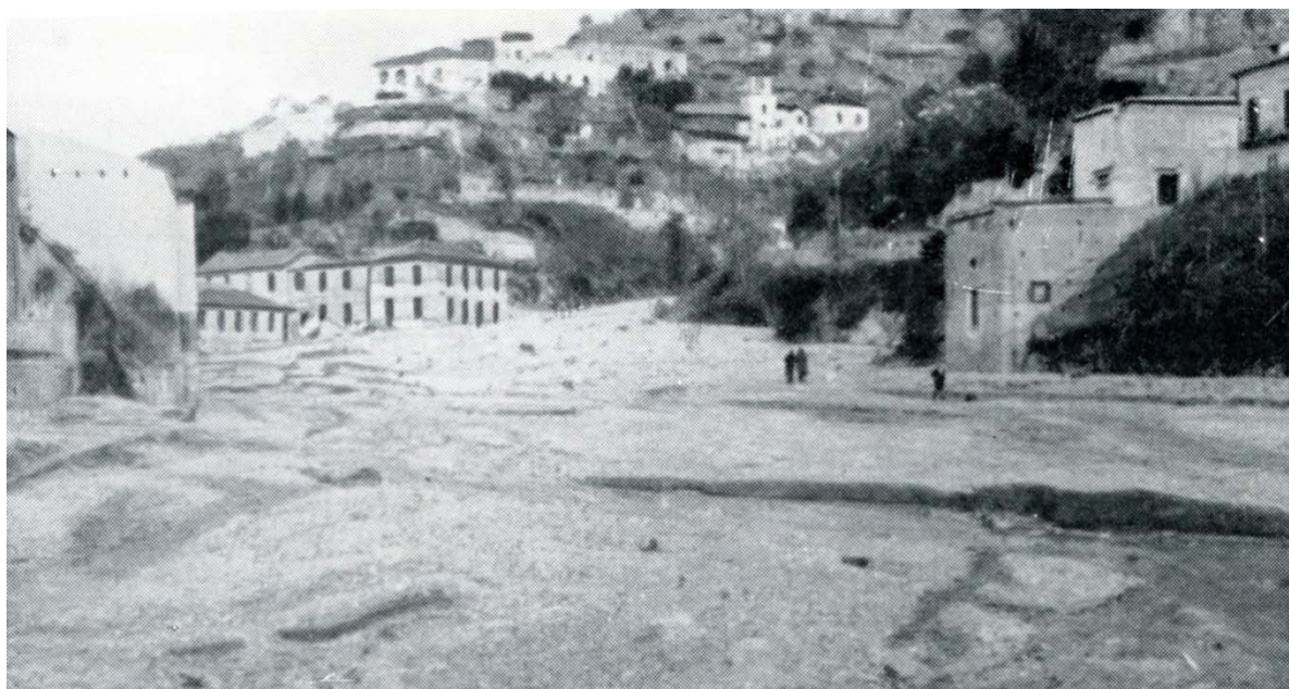
Fig. 9. La foce del torrente Reginna Maior dopo l'evento del 24 ottobre 1954 che distrusse le case di Maiori poste a lato del tombino dove era stato inalveato il torrente (che scoppiò per la pressione) come mostra il grande varco colmo di detriti [6].
