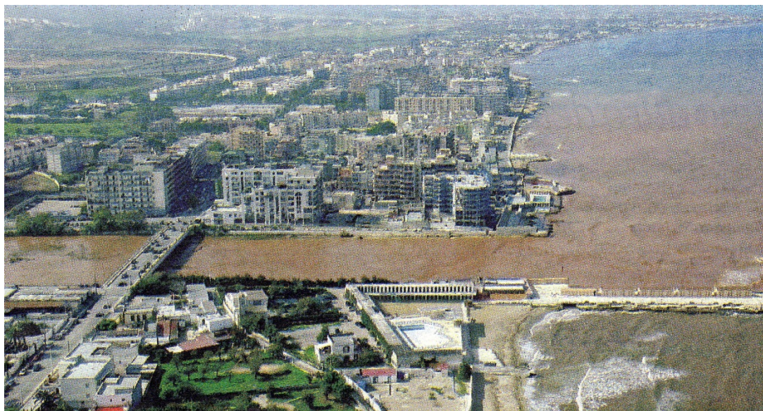
Fig. 13. Immagine della foce a Bari della Lama Sinata, dove confluisce il Picone dopo la sistemazione, il giorno 23 ottobre 2005.
