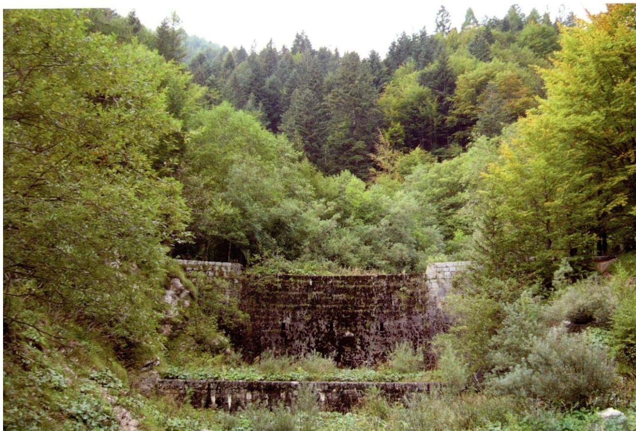
Fig. 14. Briglia curvilinea in muratura che ha dato stabilità alle pendici in forte dissesto che, rimboschite, oggi costituiscono la foresta di Giazza. Questa fu acquisita nel 1911 al demanio forestale dello stato (ASFD), in forza della legge istitutiva 2 giugno 1910 n 277, ed è oggi amministrata da Veneto Agricoltura che cura il bosco e assicura la manutenzione delle opere.
