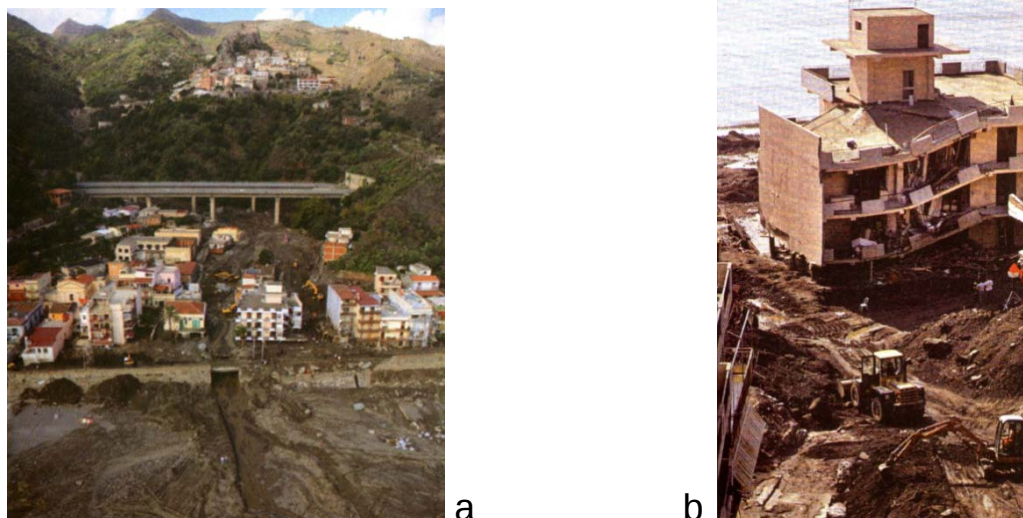
Fig. 1. L'abitato di Scaletta Zanclea (ME) allo sbocco del torrente Racinazzo dopo che esondò il 1° ottobre 2005. In a visto da valle in b visto da monte.
